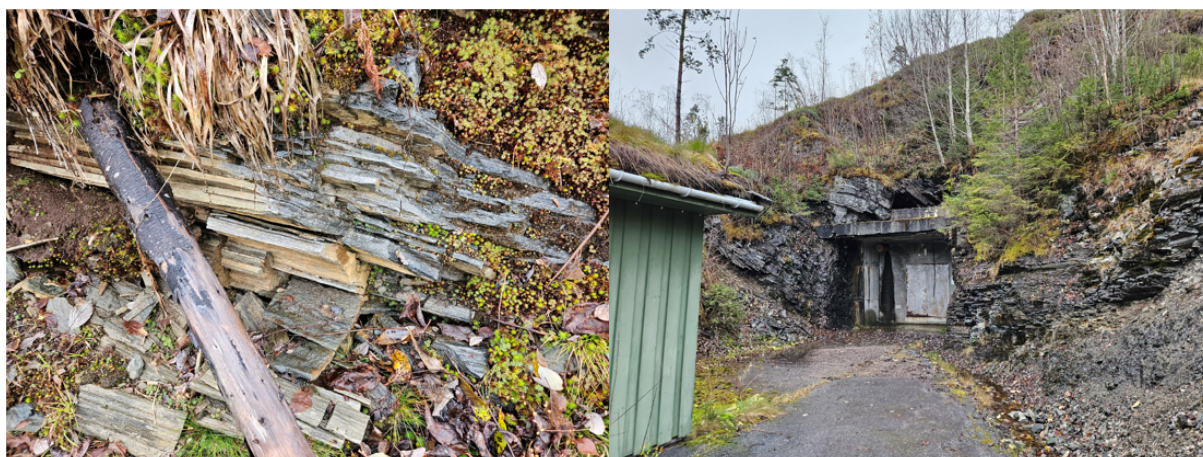
Figur 6: Bilde av antatt kvartsskifer i infopunkt P4 (foto til venstre) og fra påhuggsområdet til eksisterende høydebasseng (foto til høyre).
