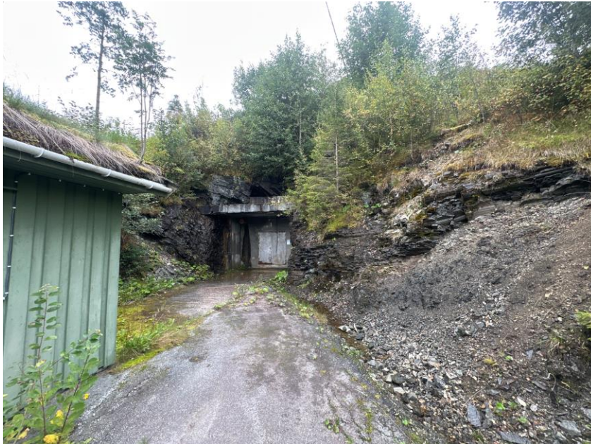
Figur 1 Dagens utsprengte basseng
